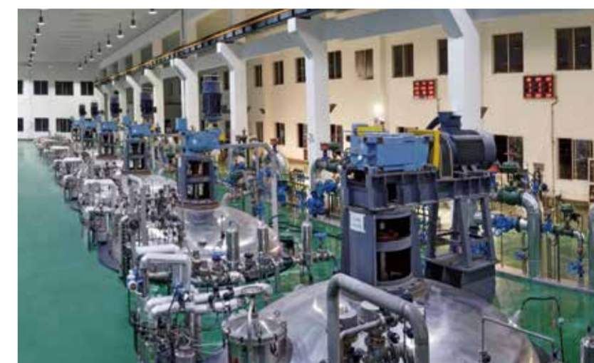
盛虹 PTT 生物基纤维生产车间。
